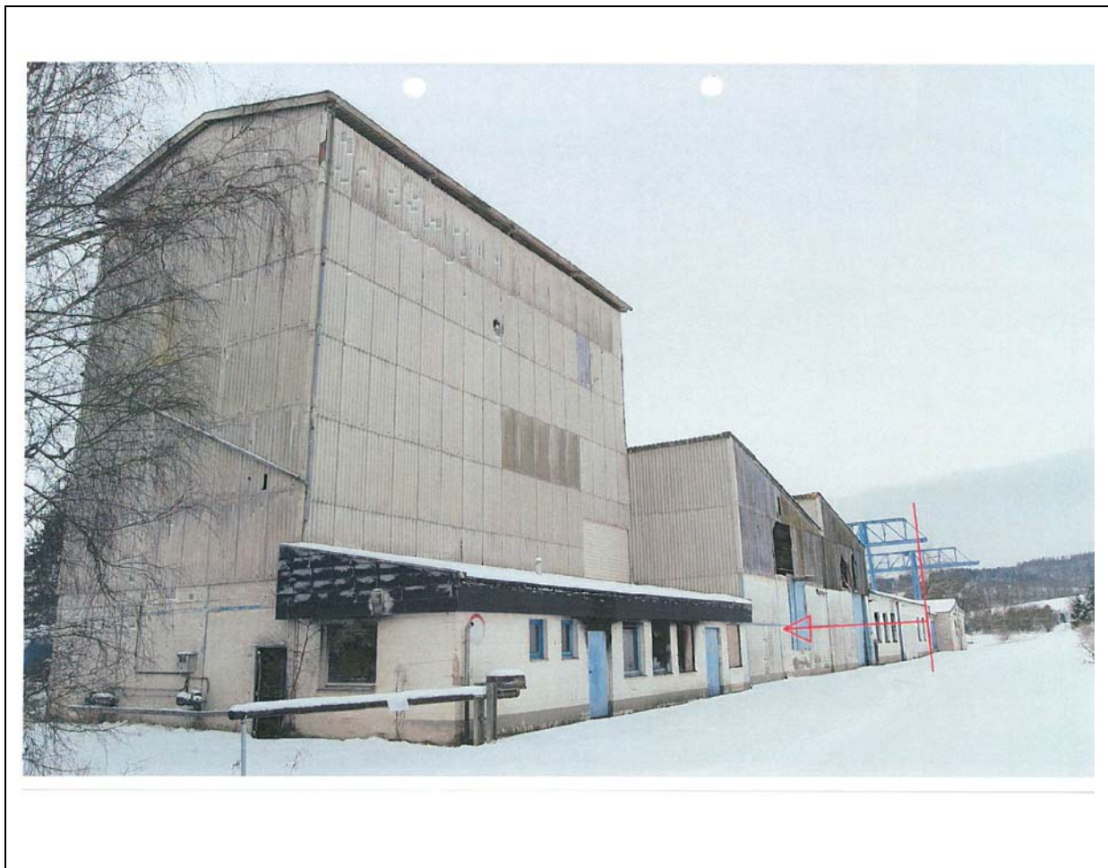
Abb. 6: Bisherige Gebäudekubaturen des ehemaligen Kalksandsteinwerkes)
