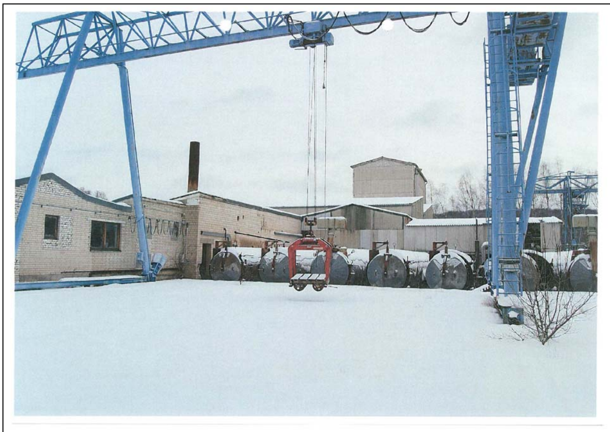
Abb. 7: Bisherige Gebäudekubaturen des ehemaligen Kalksandsteinwerkes)
