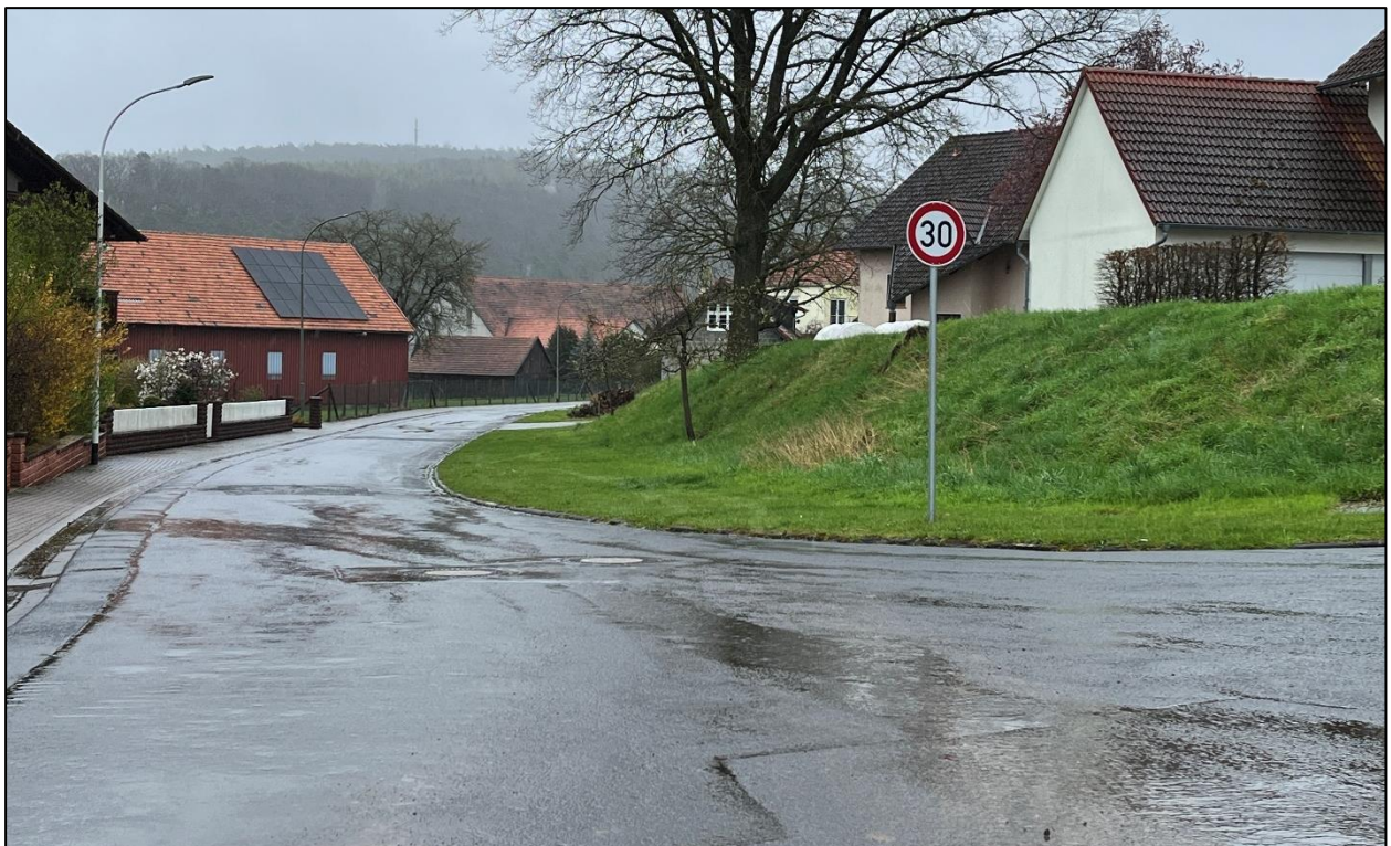
Abb. 62: Entlang der Kaiserstraße in Hartershausen verläuft ein Fließpfad von Oberflächenabflüssen (im Bild zu sehen). Es besteht keine Zuflussmöglichkeit auf die angrenzende breite Grünfläche. Als Maßnahme können Mulden auf der Grünfläche und ein Zufluss zu den Mulden von der Straße geschaffen werden. © Planungsbüro Fischer 2024
