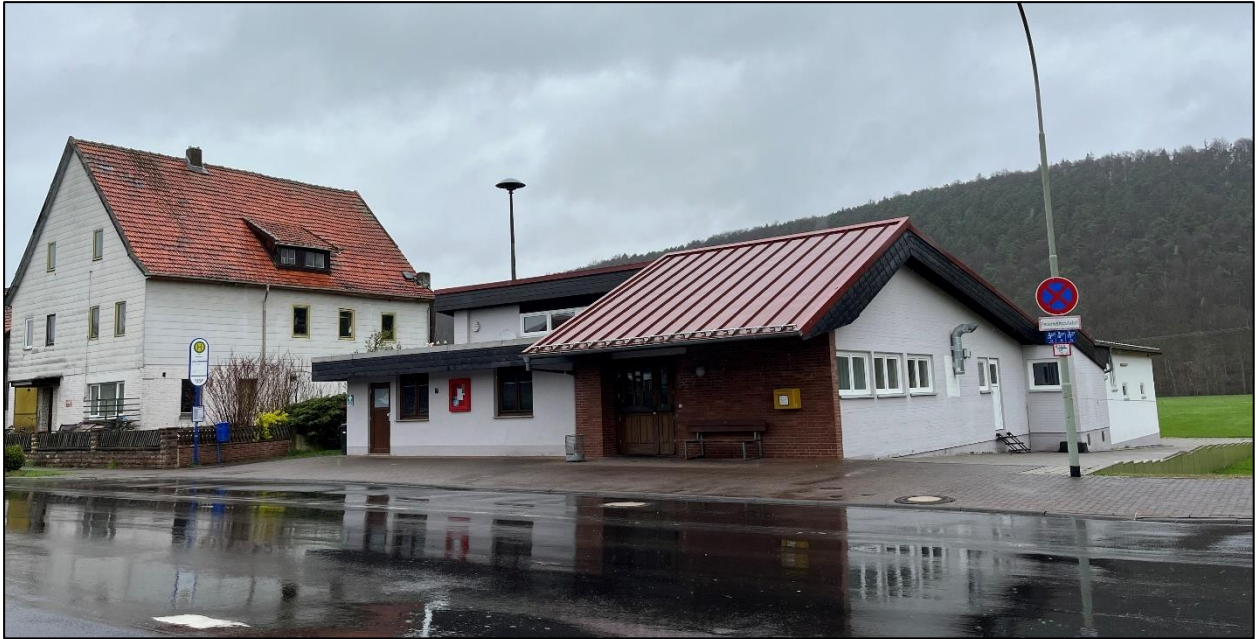
Abb. 57: Steildächer, wie hier in Hemmen, lassen sich mit einem höheren Aufwand auch begrünen. Es sind jedoch Schubsicherungen zu integrieren, damit das Substrat und die Pflanzen nicht abrutschen und das Wasser nicht so schnell vom Dach fließt (Gefahr von Trockenstress). Die Begrünung dieses Daches hätte einen stärkeren Effekt auf das Ortsbild, da diese besser von der Straße und Fußwegen einsichtig ist. © Planungsbüro Fischer 2024
