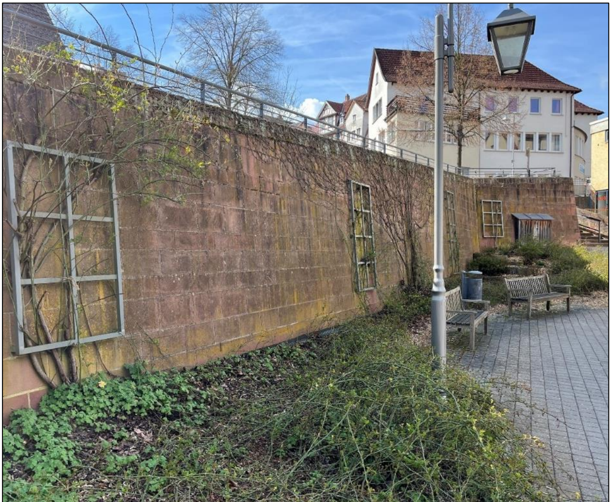
Abb. 55: Fassadenbegrünung an einer Stützmauer in der Schulstraße mit Kletterpflanzen die eine Rankhilfe benötigen und die keine benötigen. © Planungsbüro Fischer 2024
