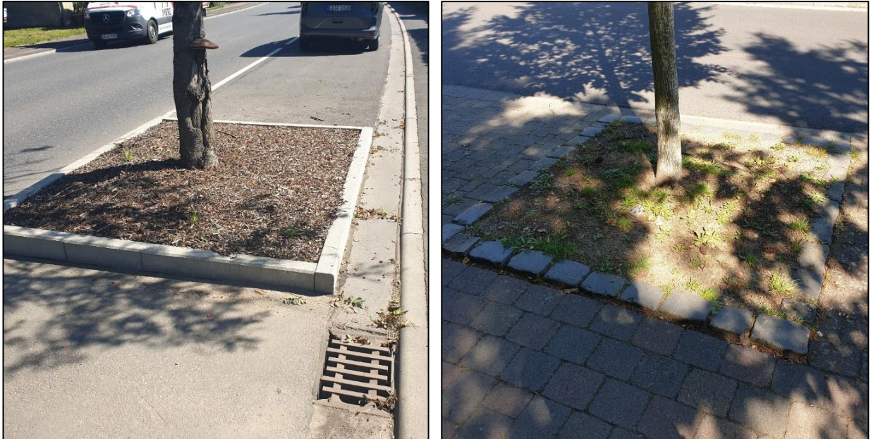
Abb. 59: Der Oberflächenabfluss wird auf dem linken Bild an der Pflanzscheibe vorbeigeführt und die geschlossene Umrandung lässt keinen Zufluss zu. Die umliegende vollständige Versiegelung lässt kein Wasser in der Nähe des Baumes versickern. Der angepflanzte Baum zeigt bereits, durch Trockenstress verursachte Schäden, die das Eindringen eines Baumpilzes förderten (Im Grund in Schlitz). Bei der Baumscheibe auf dem rechten Bild lassen die offenen Fugen der Umrandung Wasserflüsse zum Baum zu. Der umliegende gepflasterte Weg lässt eine Versickerung des Wassers in der Nähe des Baumes zu (Steinweg in Schlitz). © Planungsbüro Fischer 2023
