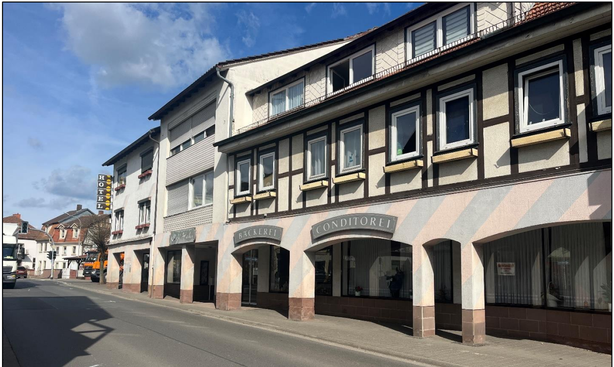
Abb. 56: Insbesondere, wenn der Straßenraum zu schmal für Begrünungselemente ist und Gebäude nah an der Straße stehen, eignen sich die Fassaden für eine Begrünung (Vorausgesetzt, dass noch genug Sonne für das Pflanzenwachstum auf die Fassade trifft). Meist ist der Bürgersteig für die Pflanzfläche im Eigentum der Gemeinde, das Gebäude jedoch in privater Hand. Eine Abstimmung mit dem Hauseigentümer ist daher erforderlich, um das Rankgerüst an der Fassade anbringen zu können. © Planungsbüro Fischer 2024
