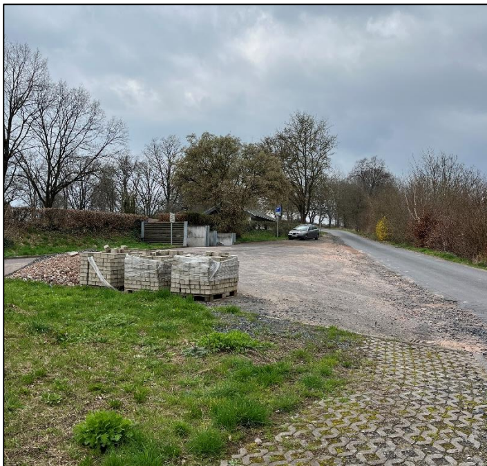
Abb. 44: Parkplatz am Friedhof Nieder-Stoll. Die dreieckige Flächenform des Parkplatzes lässt Raum für Begrünungselemente
