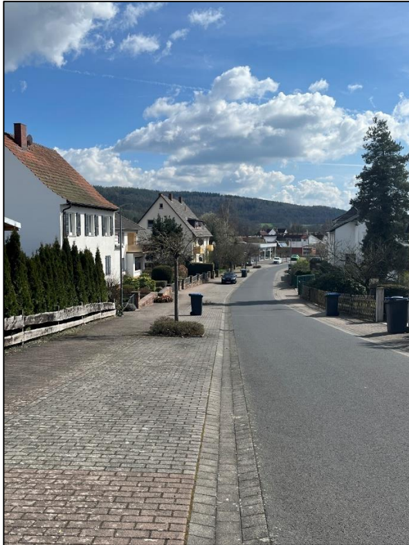
Abb. 61: Entlang der Schillerstraße in Schlitz verläuft ein potenzieller Fließpfad von Oberflächenabflüssen (Fließpfad laut Fließpfadkarte Schlitz, HLNUG 2023). Der Abfluss wird an den Baumscheiben vorbeigeleitet. Als Maßnahme wären hier Baumrigolen zu empfehlen und eine Zuleitung der Oberflächenabflüsse zu den Baumscheiben. Förderlich wären auch weniger versiegelte und begrünte Parkplatzflächen, die die Versickerung von Regenwasser fördern. Der Straßenraum erlaubt zudem größere Bäume (z.B. Platanen, Baumhaseln), statt die gepflanzten Kugelbäume. © Planungsbüro Fischer 2023
